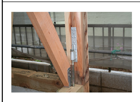
(3) 柱頭柱脚金物 ホールダウン金物
