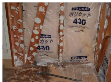
▼断熱材の充填(外壁)
